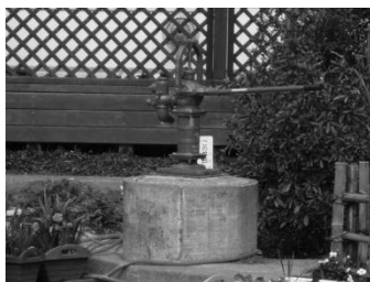
新しい井戸ポンプ
